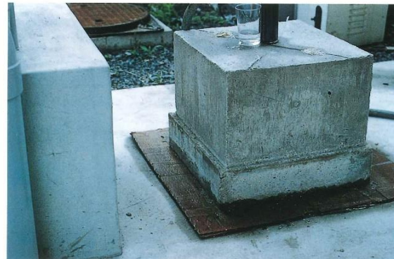
③ ②の工程後、直ちにコンクリート打設 (375mm×375mm H250mm)
