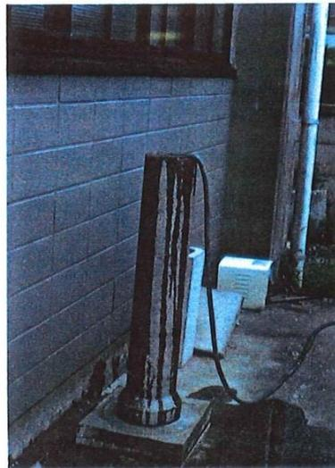
注水開始後架台継目より激しく漏水。10分程度でパイプ内の水がなくなる
