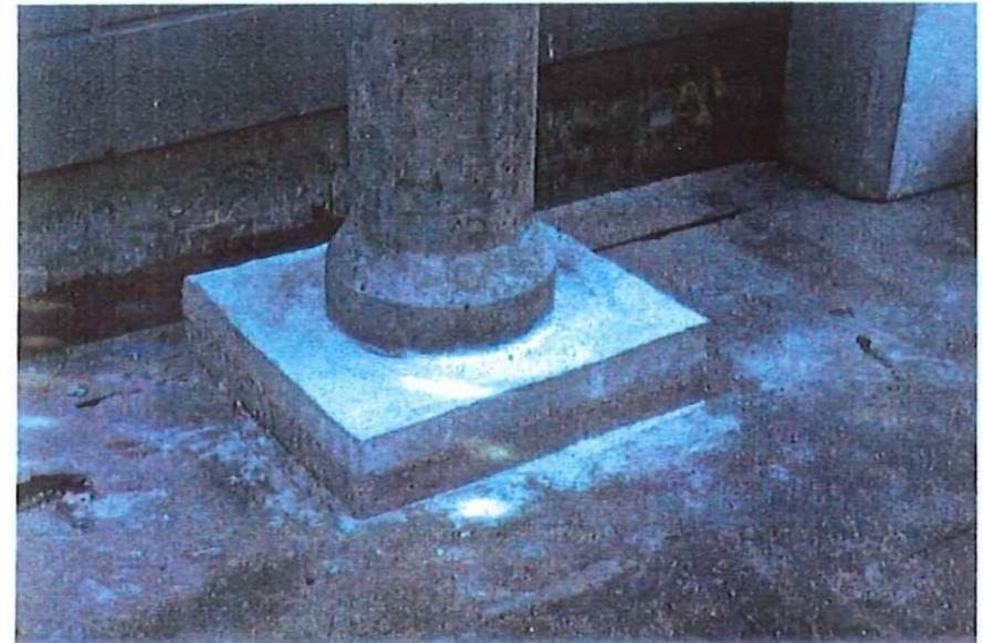
12時間放置後パイプ内満水にするも完全に止水。…2年経過後も漏水は無し。
